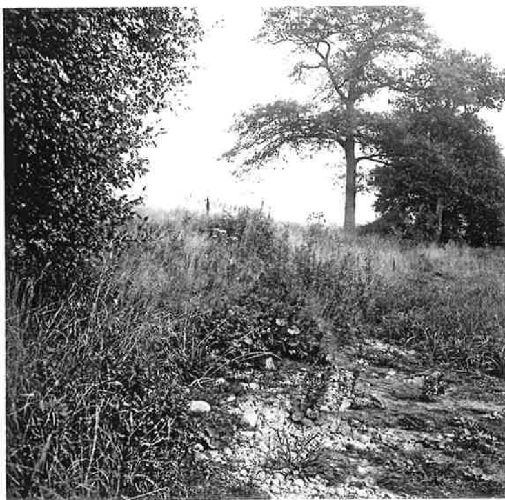
Fig. 31 Vombsjön. Strandparti med erosionskant i den övre delen av "Sjömanslagarna". 19 september 1967.
