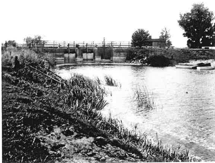
Fig. 144 Vombsjön. Regleringsdammen från sjöbilden. 15 september 1967.
