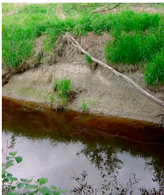
Figur 44. Fridykning är speciellt lämplig i vattendrag där ingen annan metod fungerar, t.ex. vid höga strandbrinkar. Kilaån, Södermanlands län.
