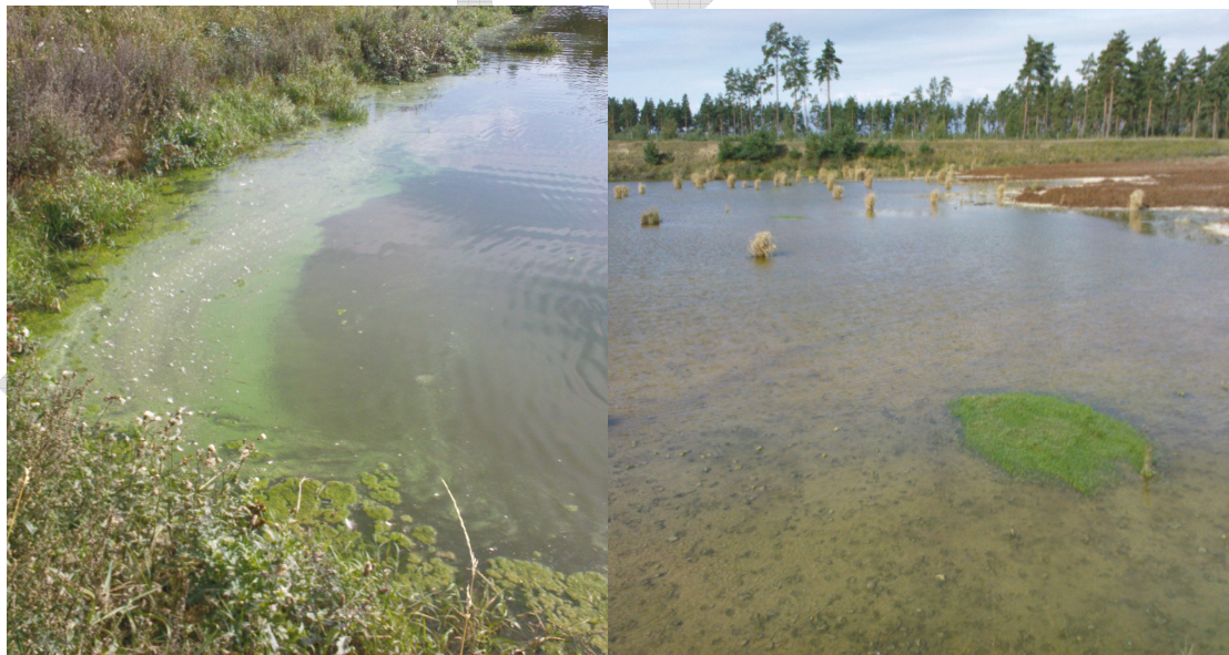
Figur 5.2: Damm 16 till vänster och damm 32 till höger. Infiltrationsdammar sommaren 2007. Sannolikt cyanobakterier i damm 16, ogräs i damm 32.
