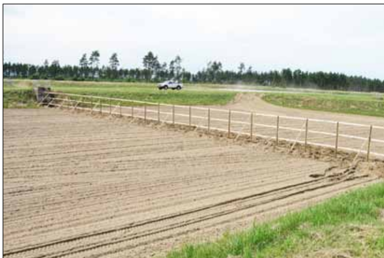
Figur 6-2 Delningsväggen under konstruktion i den ena av infiltrationsdammarna. Thomsonöverfallet sitter i den grå betongkonstruktionen i bildens vänstra kant.
